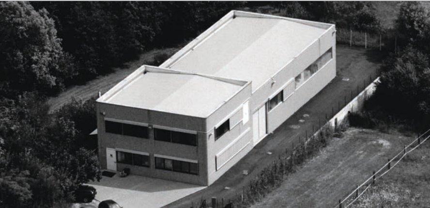
LO STABILIMENTO DI PRODUZIONE DI LESSOLO (TO)
