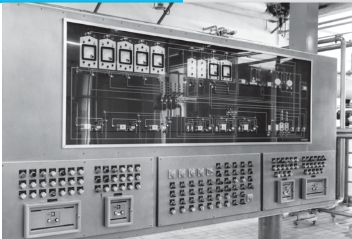
FIG. 11 - QUADRO DI AUTOMAZIONE, 1975
